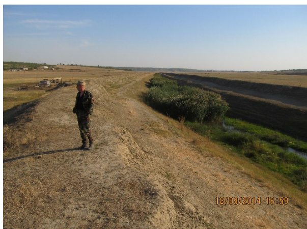
Когылник, ниже г. Комрат. Противопаводковый вал и перепад высот поймы (слева) и зарегулированной реки (справа)
